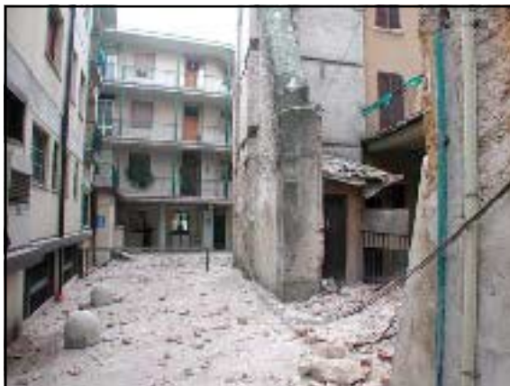
Crolli nei pressi della Chiesa di S. Bernardino
