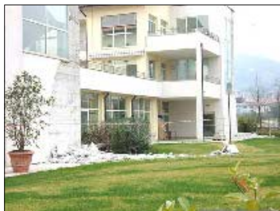
La Casa di Riposo, con gli evidenti effetti causati dal terremoto
