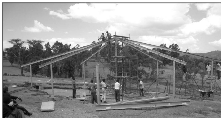
Il montaggio di una struttura della scuola
